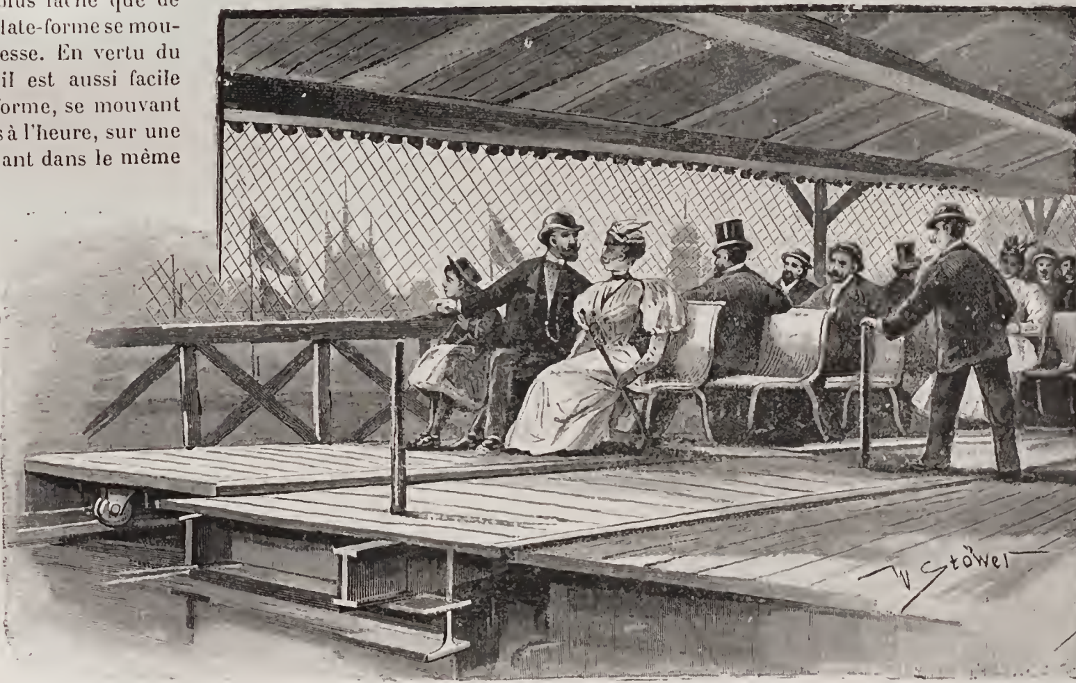
LES TROTTOIRS MOBILES. — Installation des sièges pour les voyageurs et coupe fixe montrant la construction de la voie.
